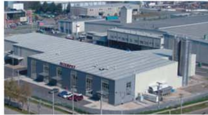
Productions centre for STARstrap™ strapping in Chile Centre de production pour les feuillets de cerclage STARstrap™ au Chili Produktionswerk für STARstrap™ Bänder in Chile
